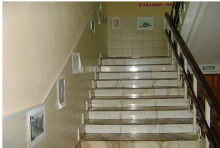
Фото № 23 лестница внутри здания
