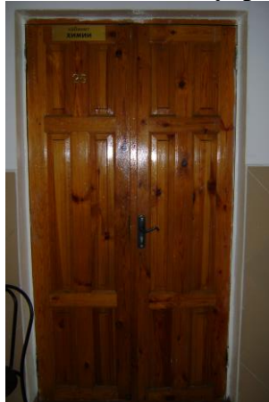
Фото № 25 дверь внутри здания
